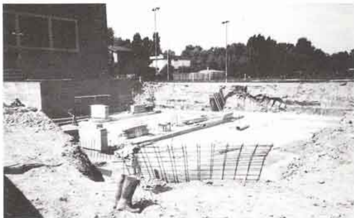
1986 - Inizio dei lavori
